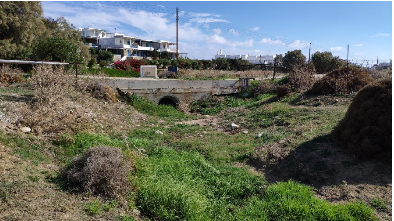
Εικόνα 17: Τεχνικό διάβασης με κυκλικό οχετό Φ1000 (Χ.Θ. 389.93)
