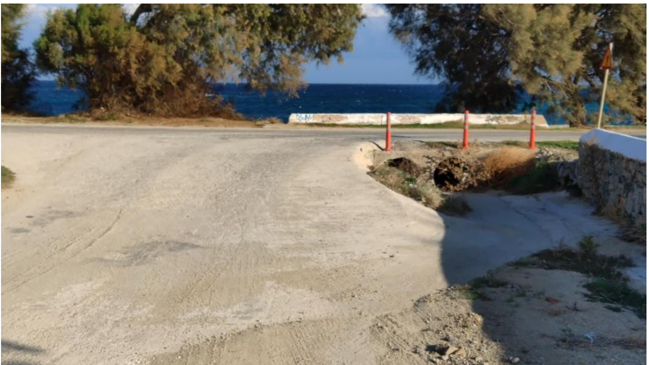
Εικόνα 22: Τεχνικό διάβασης παραλιακής οδού (Χ.Θ. 7.7)
