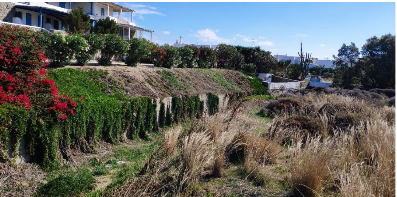
Εικόνα 18: Ρέμα κατάντη του τεχνικού
