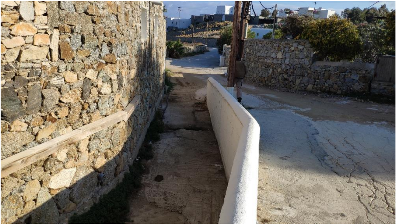
Εικόνα 21: Εκβολή ρέματος στη σκυρόδετη οδό (Χ.Θ. 204)
