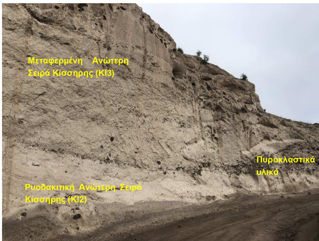
Εικ. 3-1 Χαρακτηριστική τομή, όπου φαίνεται η στρωματογραφία της περιοχής μελέτης.
