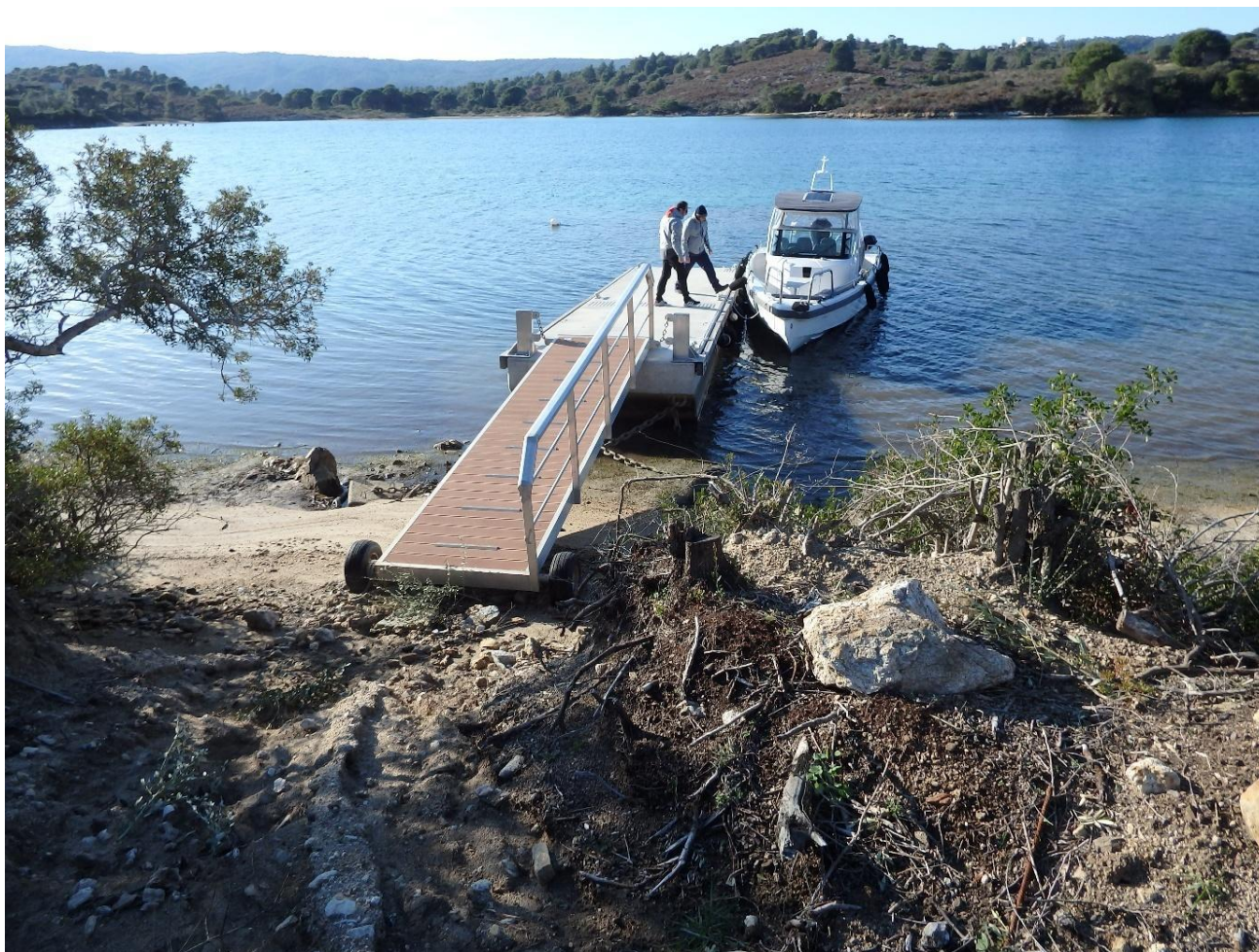
Εικόνα 4-7 Πλωτός προβλήτας από σκυρόδεμα εποχικής χρήσης
