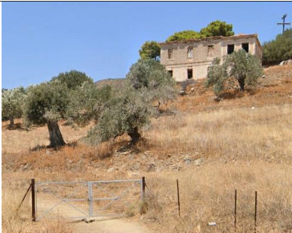
Εικόνα 1-8 Φωτογραφία επί χωμάτινης οδού, βόρεια της επαρχιακής οδού που διασχίζει το οικοπέδο με διεύθυνση λήψης προς Βορρά, στη θέση 7.
