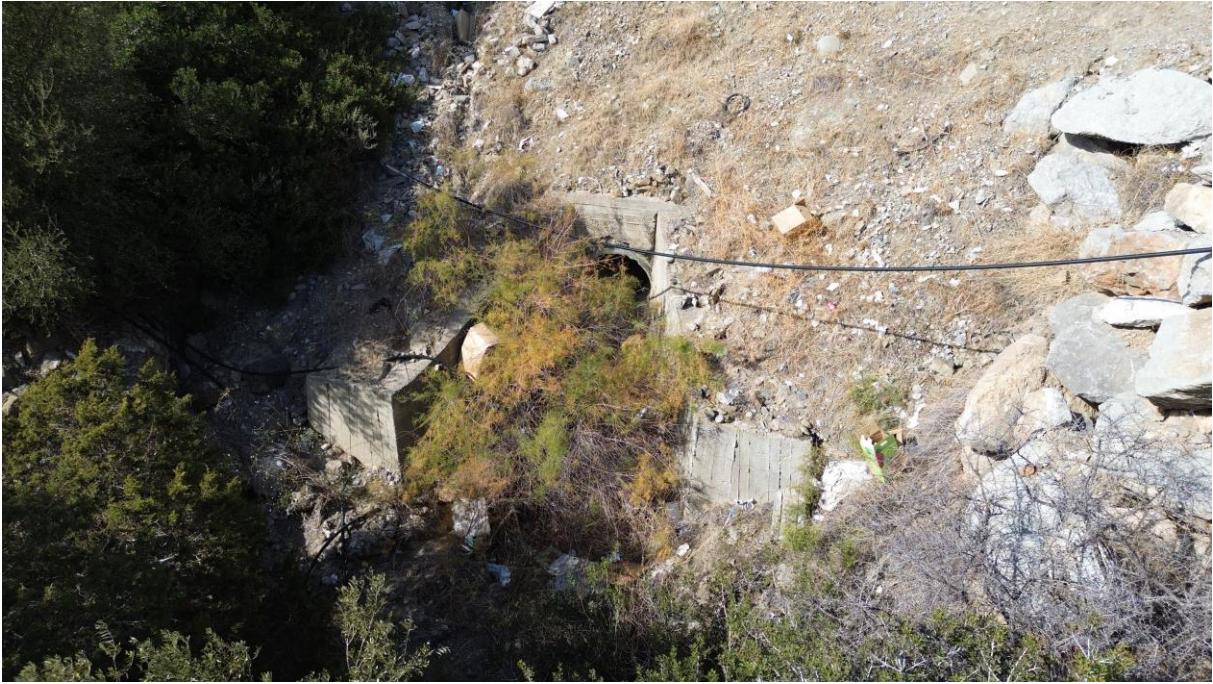
Φωτογραφία 9 Εκβολή αγωγού κατάντη της δημοτικής οδού. Λήψη προς Β
