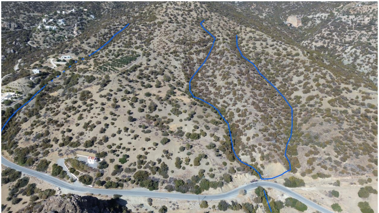
Φωτογραφία 10 Από αέρος λήψη της ευρύτερης περιοχής του έργου από νότο προς βορρά. Διακρίνεται το υδρογραφικό δίκτυο στην ευρύτερη περιοχή του έργου. Στα δυτικά διακρίνεται το Δυτικός Κλάδος όπου στο πιο ανάντη τμήμα του προς την μεριά του έργου δεν διαμορφώνεται σαφής μισγάγγεια
