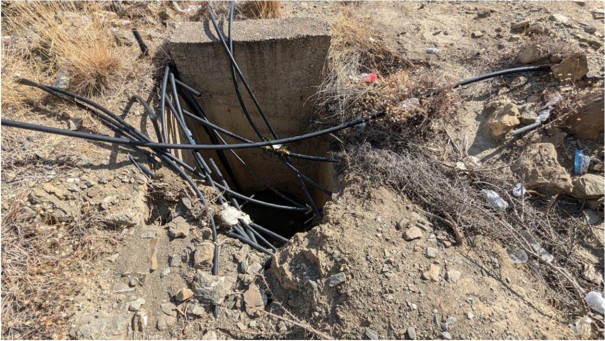
Εικόνα 5-3 Φρεάτιο πτώσης στη συμβολή των κλάδων ανάντη της δημοτικής οδού
