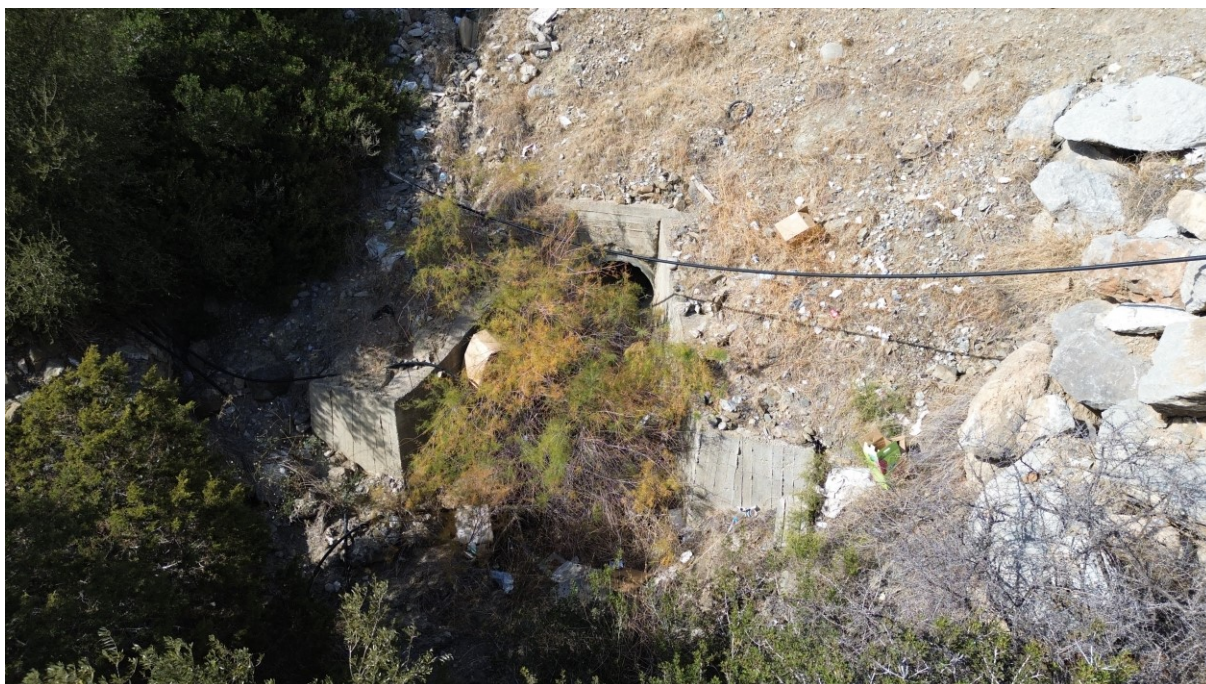
Εικόνα 3-7 Εκβολή αγωγού κατάντη της δημοτικής οδού (κλάδος Α1)
