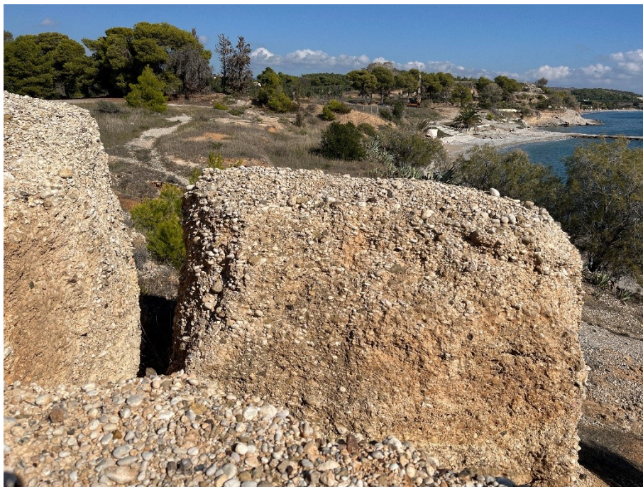
Εικόνα 22. Αποψη ογκόλιθου που έχει αστοχήσει κατά μήκος των παράκτιων πρανών στα ΝΔ τμήματα της περιοχής.
