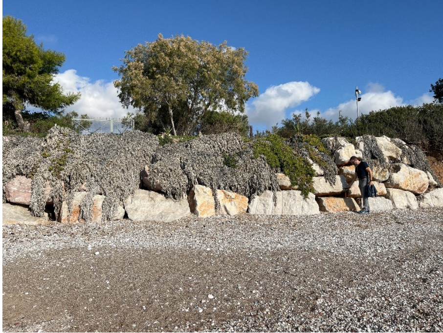
Εικόνα 24. Αντιδιαβρωτικά μέτρα κατά μήκος των πρανών της παράκτιας ζώνης σε παρακείμενη ιδιοκτησία.
