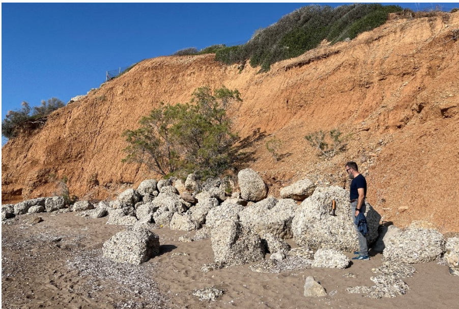
Εικόνα 16. Αποψη υλικών καταπτώσεων (mw) κατά μήκος της παράκτιας ζώνης.
