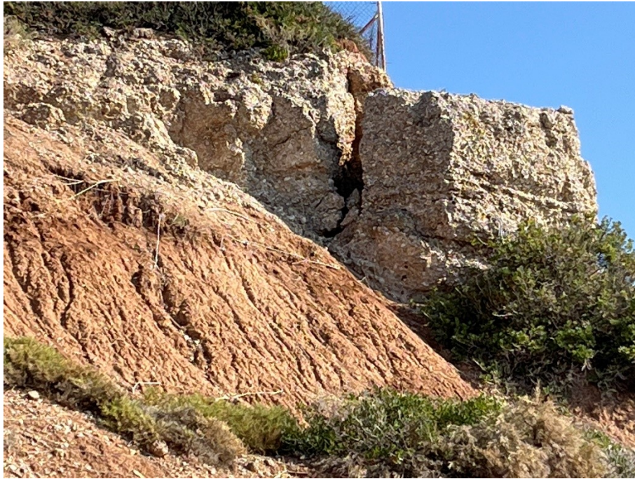
Εικόνα 21. Αποψη επικρεμάμενου ογκόλιθου που έχει αποκολληθεί και είναι έτοιμος να κατολισθήσει από τα πρανή της παράκτιας ζώνης.
