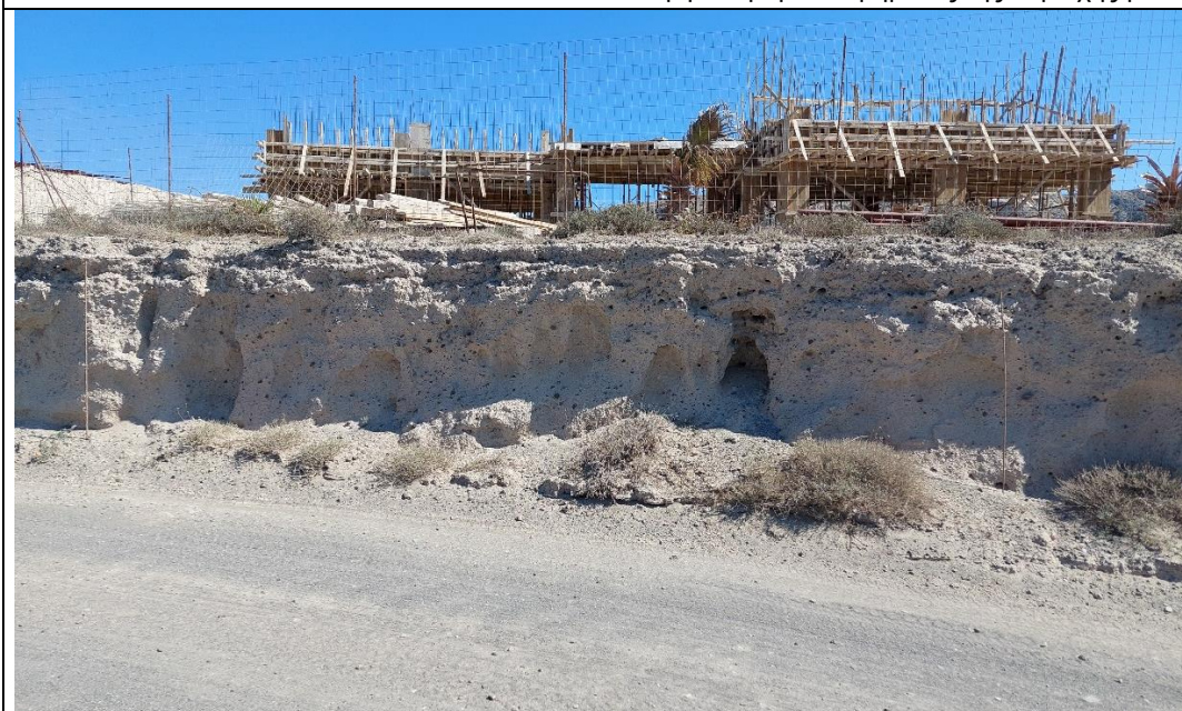
Φωτο 18: άποψη πρόσφατου κατακόρυφου πρανούς οδοποιίας στην ανώτερη μεταφερμένη σειρά κίσσηρης ύψους περίπου 2 μέτρων θέση Παρατήρησης Π5
