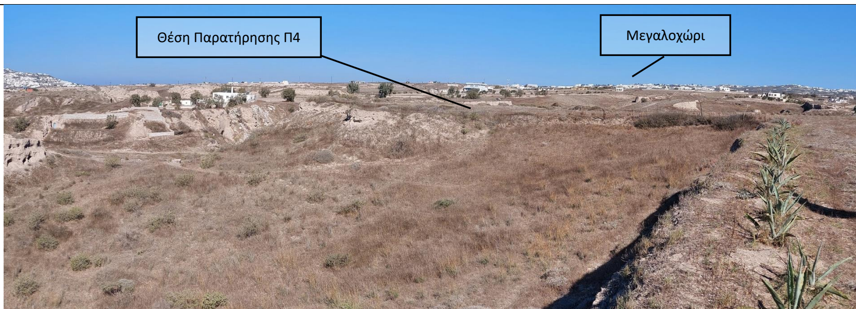
Φωτο 11: άποψη τμήματος του ακινήτου προς την θέση Παρατήρησης Π4 και προς Βορρά
