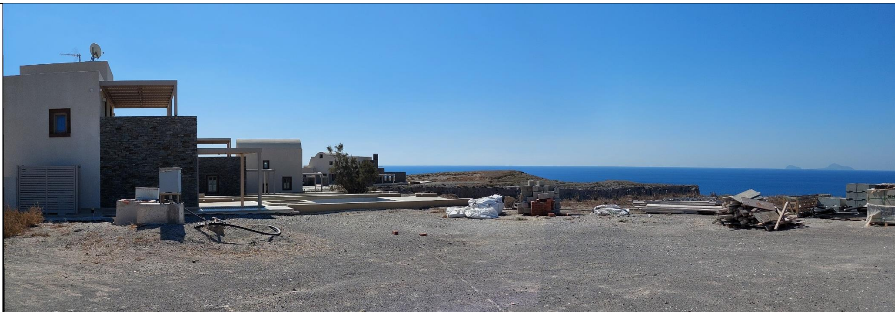
Φωτο 7: Άποψη περιοχής παρά το δυτικό όριο της περιοχής μελέτης, με υλοποιημένες κατασκευές από Βορρά προς Νότο προς την ακτή Θέση Παρατήρησης Π3
