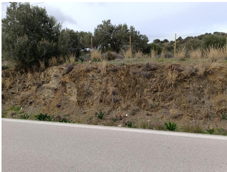
Φωτογραφία 22: Εμφάνιση φλύσχη επί της Επ. Οδού στη χ.θ. 17+740.
