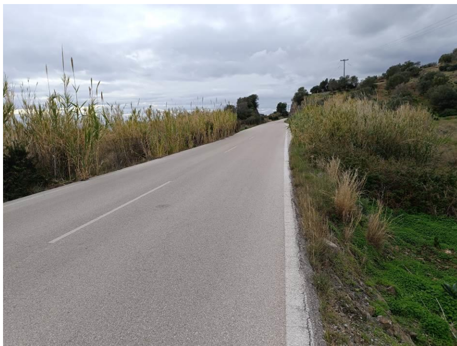
Φωτογραφία 12: Επίχωμα σε θέση περί τη χ.θ. 17+000 της Επαρχιακής οδού.
