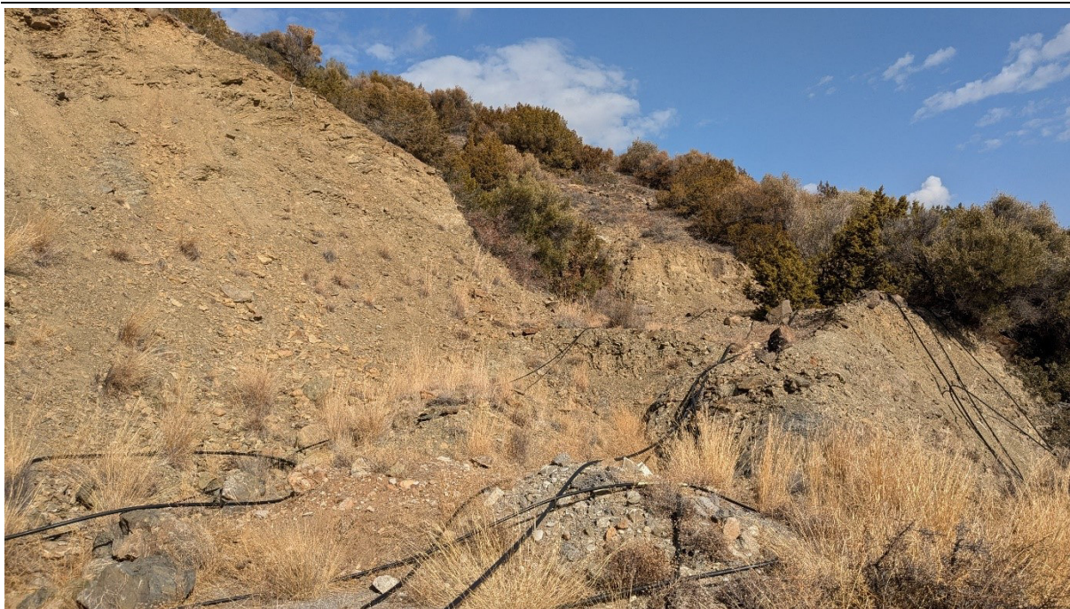
Εικόνα 3-11. Ψαμμιτικός φλύσχος επί του επαρχιακού δρόμου στη συμβολή των δύο ρεμάτων. Λόγω του έντονου τεκτονισμού ο ψαμμιτικός φλύσχος έχει χάσει την εσωτερική του δομή γίνεται φυλλιτικός. (Χ: 624336, Υ: 3873279).
