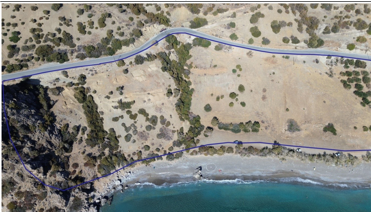
Εικόνα 2-7. Πανοραμική άποψη της Έκτασης 3 και τμήμα της Έκτασης 4 από κατάντη προς ανάντη
