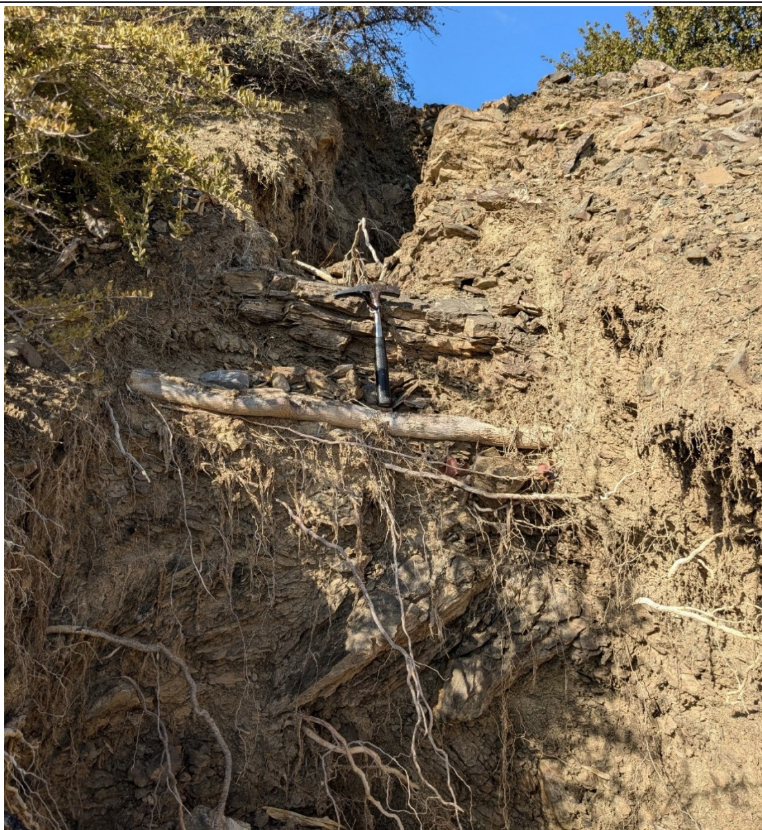
Εικόνα 3-14. Ιλυολιθικός φλύσχη στο χώρο του οικοπέδου που έχει διαβρωθεί λόγω επιφανειακής απορροής. Διακρίνονται, ο εδαφικός σχηματισμός που καλύπτει το φλύσχη και στρώσεις του λεπτοστρωματώδη ιλυόλιθου. Διακρίθηκαν επίσης λατύπες από ραδιολαρίτες και οφιόλιθους (Χ: 624155, Υ: 3873288).
