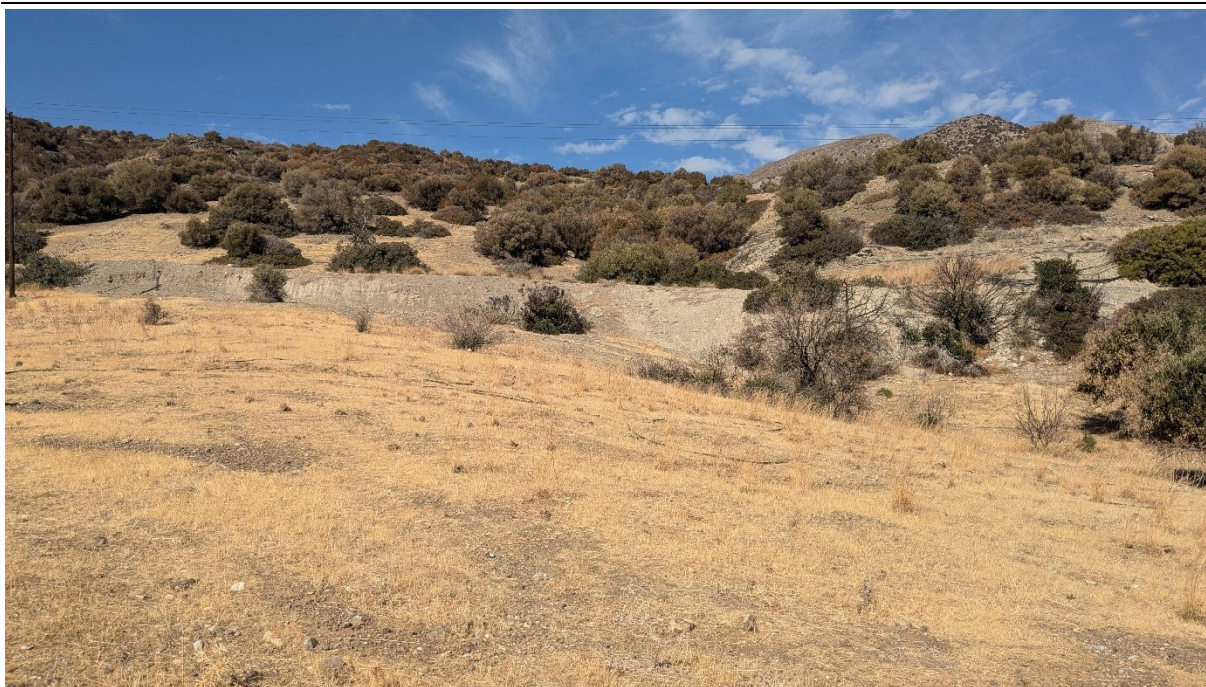
Εικόνα 3-24. Άποψη του πρανούς επί του οποίου εδράζεται το οδικό δίκτυο (Χ: 624478, Υ: 3873245)
