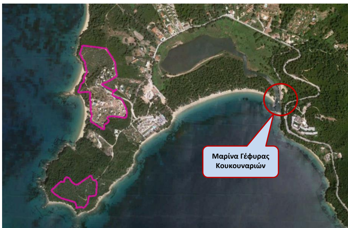
Σχήμα 6.3-7: Λιμενικές εγκαταστάσεις στην ευρύτερη περιοχή του Έργου
