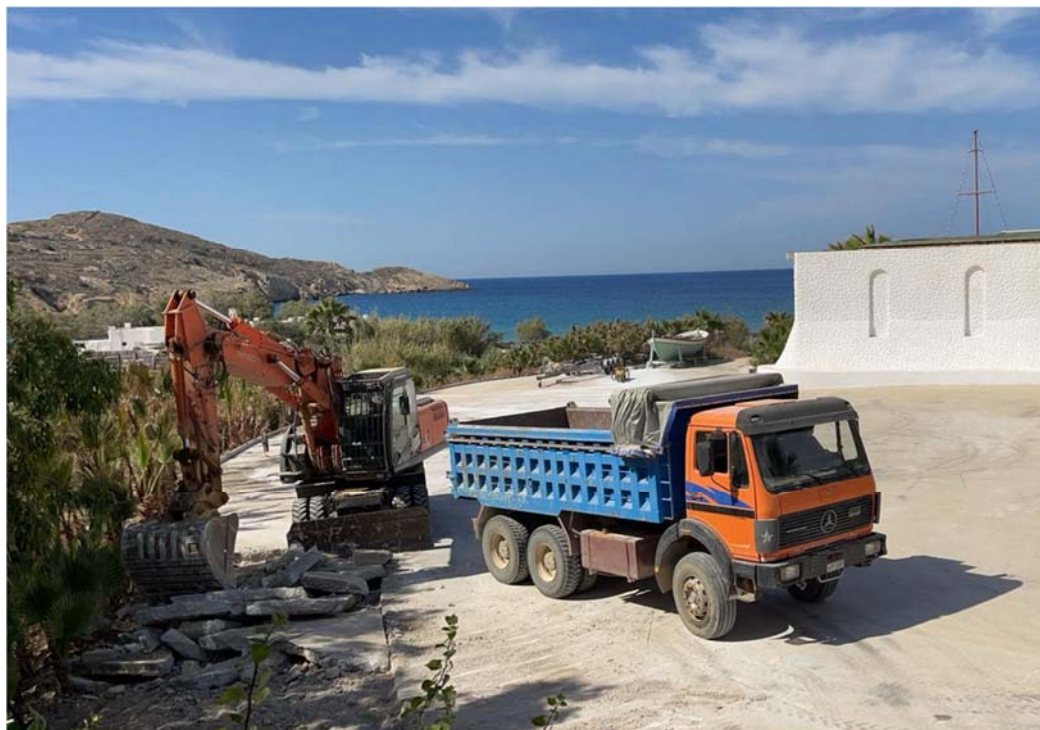
Εικόνα 8.4-9: Εργασίες κατεδάφισης τμήματος του parking του Erego
