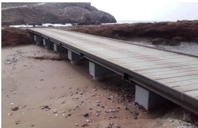
Εικόνα 4.6-8: Μέθοδος και υλικά κατασκευής γεφυρών σύνδεσης Κουμπάρας -Διακοφτού
