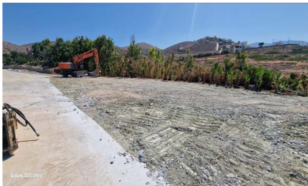
Εικόνα 8.4-10: Απομάκρυνση μπετόν τμήματος του parking του Erego
