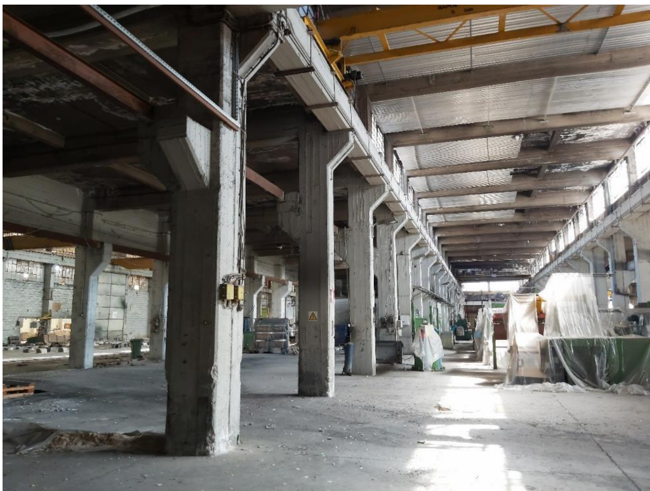
Φωτογραφία 6: Διατηρητέο Κτίριο 24 - 24 α
