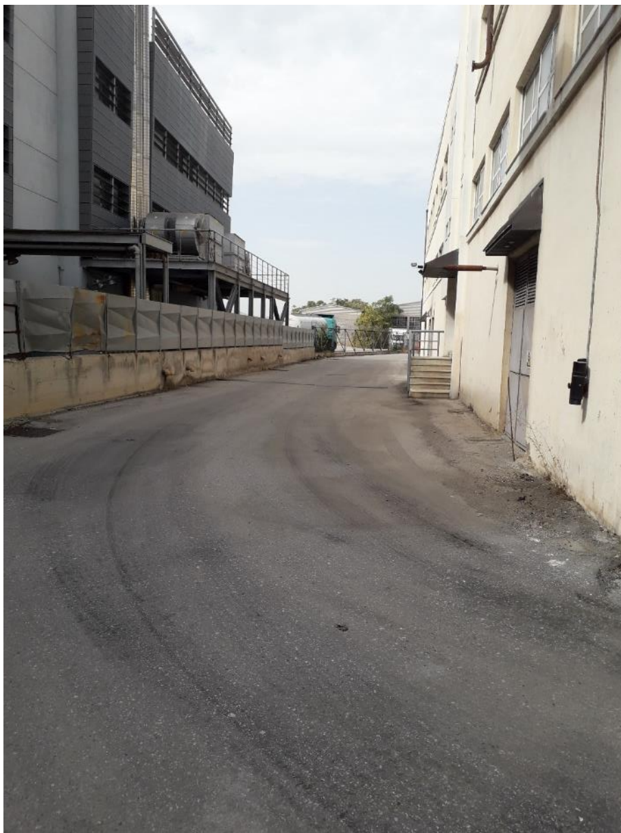
Φωτογραφία 10: Πεζόδρομος, τμήμα μεταξύ διατηρητέου Κτιρίου 7 (δεξιά) και ιδιοκτησίας ΙΜΕ (αριστερά)
