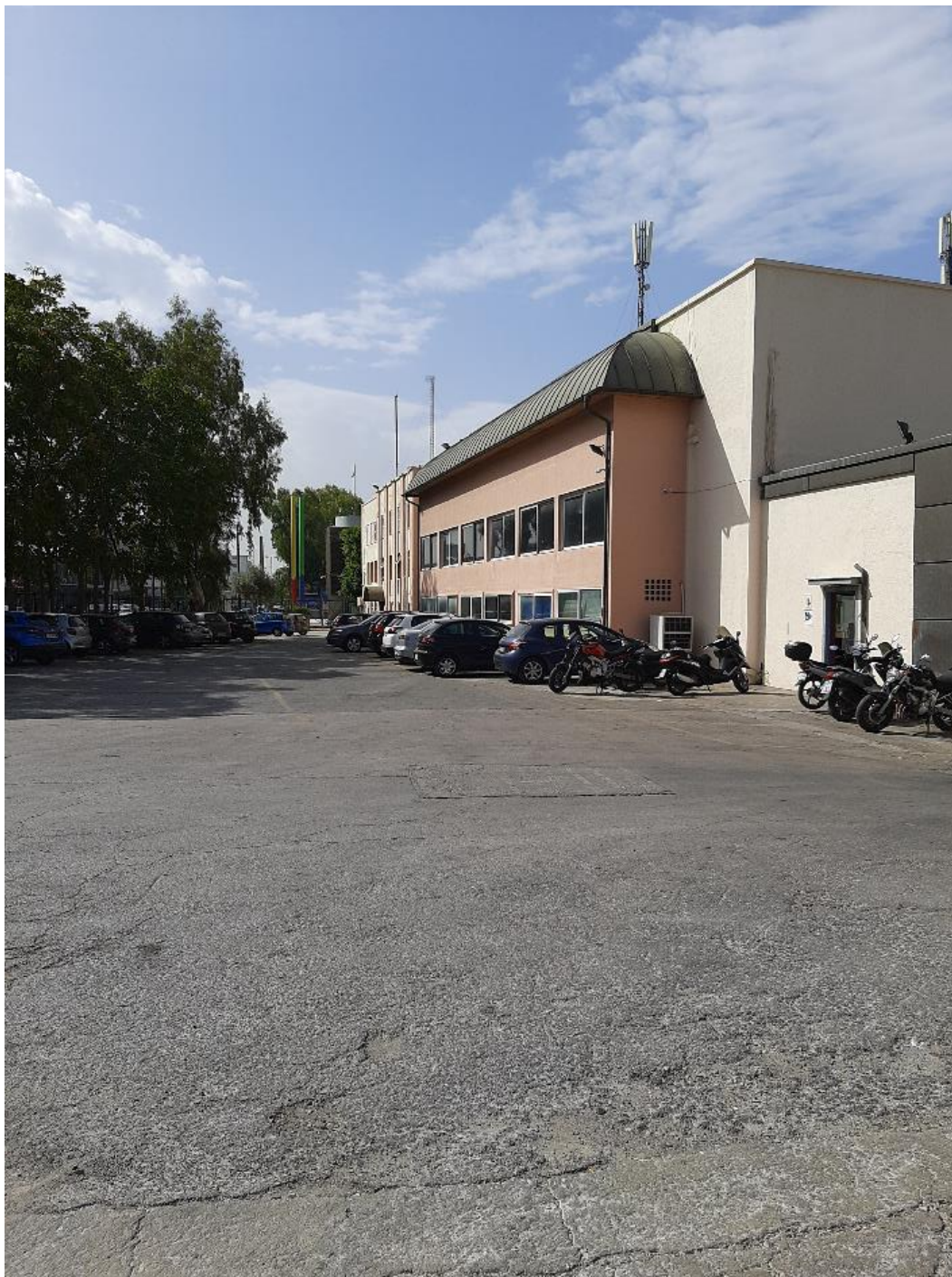
Φωτογραφία 4: Είσοδος του πρώην εργοστασίου της ΧΑΛΚΟΡ και χώρος στάθμευσης (κτίρια 25, 24β)
