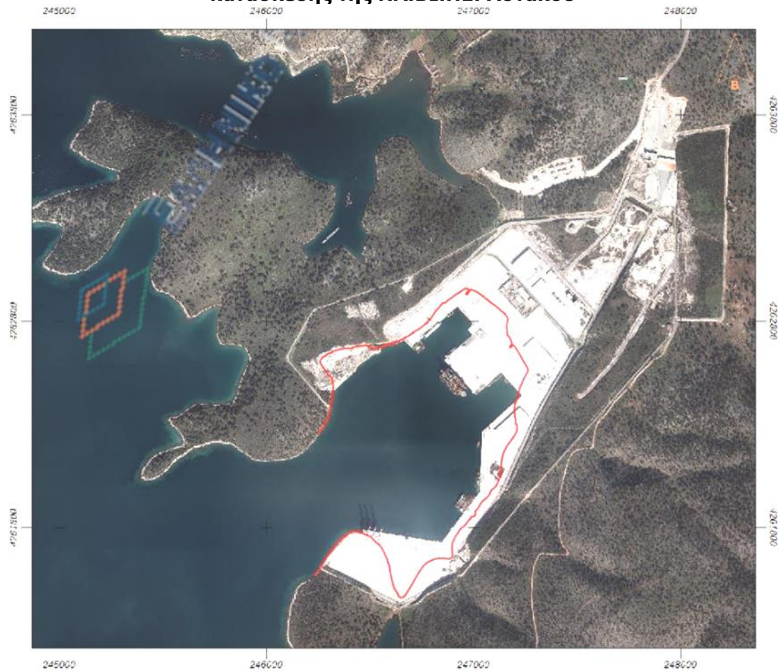
Εικόνα 26: Αλλοίωση της φυσικής ακτογραμμής (κόκκινη γραμμή) λόγω κατασκευής της ΝΑ.ΒΙ.ΠΕ. Αστακού
