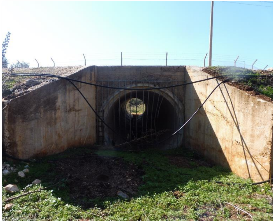
Φωτ.2.1. Το τεχνικό εισόδου του υδατορέματος 1B στις εγκαταστάσεις της ΝΑ.ΒΙ.ΠΕ. [Πηγή: GREEN2SUSTAIN pcc, 2022]
