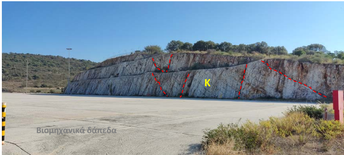
Φ12. Άποψη των επιμέρους διαρρήξεων καθώς και της στρώσης των ασβεστολίθων (Κ), υπό τα στοιχεία 27^{\circ}/325^{\circ} .
