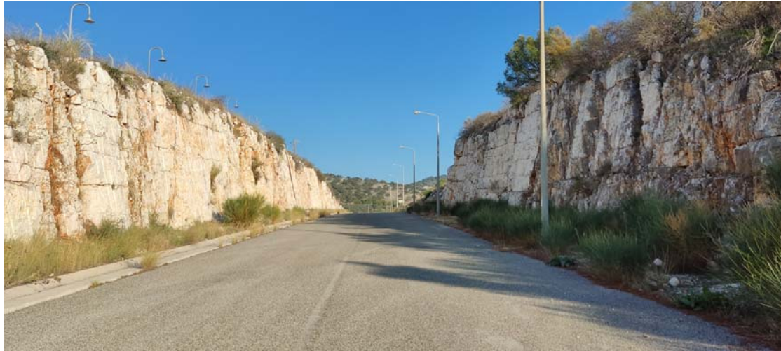
Φ26. Αμφίπλευρο ασβεστολιθικό όρυγμα στο ΒΔ όριο του γηπέδου.
