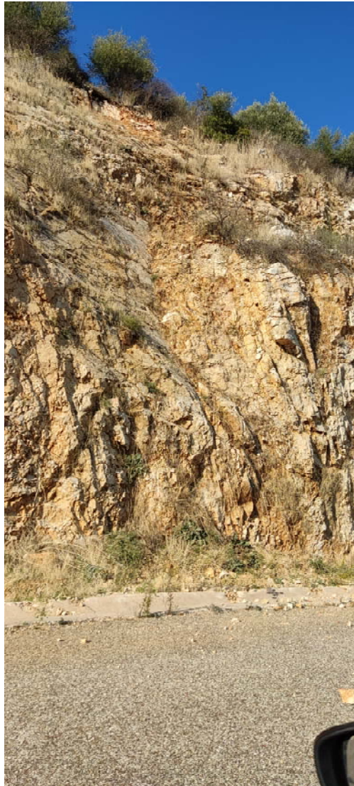
Φ21.. Άποψη ασβεστολιθικών πρανών δυτικής περιμετρικής οδού
