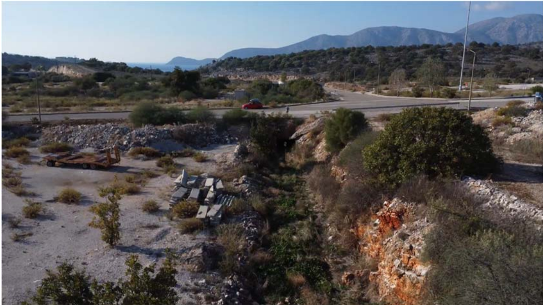
Φ28. Άποψη κοίτης υδατορέματος «2B»
