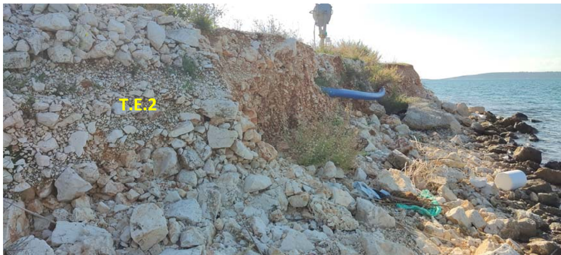
Φ13. Γλικά επιχωμάτων (T.E.2), όπως εμφανίζονται στο νοτιοδυτικό παραλιακό μέτωπο του γηπέδου κάτω από σκυροδετημένο κρηπίδωμα.
