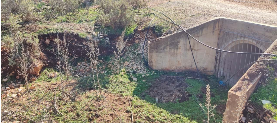
Φ1. Άποψη οχετού στην είσοδο της ΒΙ.ΠΕ.
