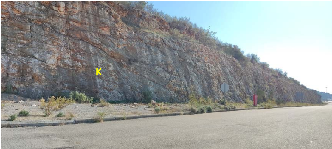
Φ7. Άποψη διαρρήξεων και διακλάσεων εντός των Ασβεστολίθων (Κ).
