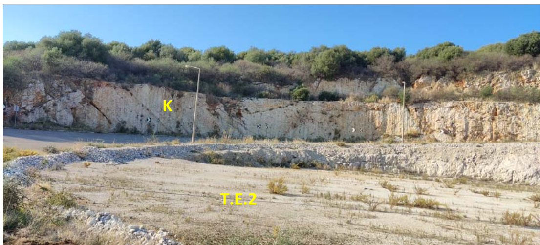
Φ18. Άποψη των υλικών επιχωμάτων (T.E.2) και των ασβεστολίθων (K), στο βορειοδυτικό τμήμα του γηπέδου.
