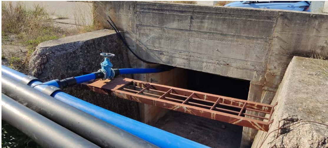
Φ8. Τετραγωνικός οχετός, για στην ασφαλή όδευση του υδατορέματος κάτω από το κρηπίδωμα.
