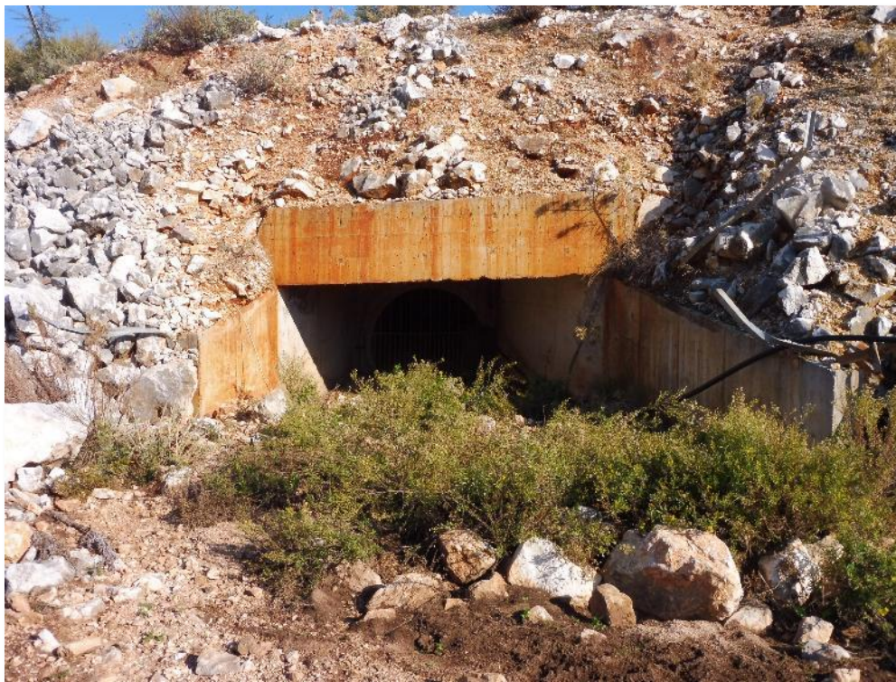
Φωτ.2.2. Το τεχνικό εξόδου του υδατορέματος 1B από τις εγκαταστάσεις της ΝΑ.ΒΙ.ΠΕ.
