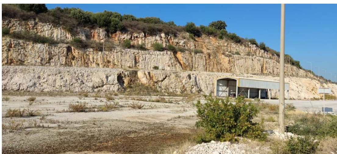
Φ19. Άποψη ασβεστολιθικών πρανών και ζώνης διέλευσης ρηγμάτων.
