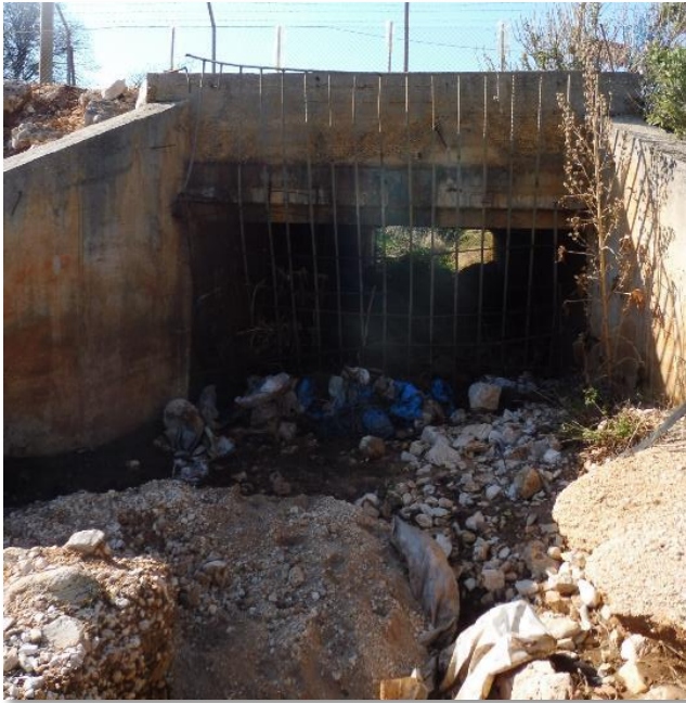
Φωτ.2.3.. Τεχνικό εισόδου του υδατορέματος 2B στις εγκαταστάσεις της ΝΑ.ΒΙ.ΠΕ.
