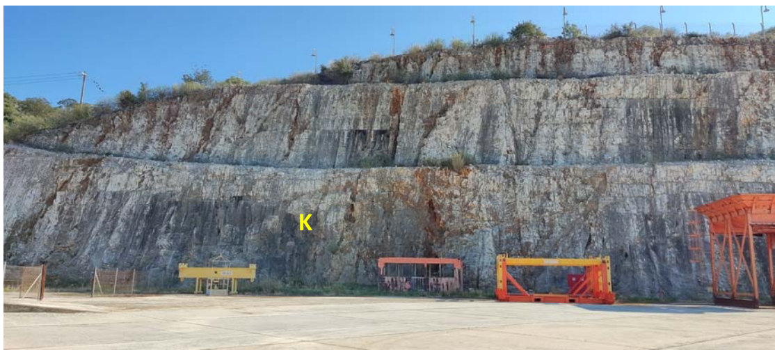
Φ9. Άποψη των συστηματικών διαρρήξεων εντός ασβεστολιθικού πρανούς (Κ).
