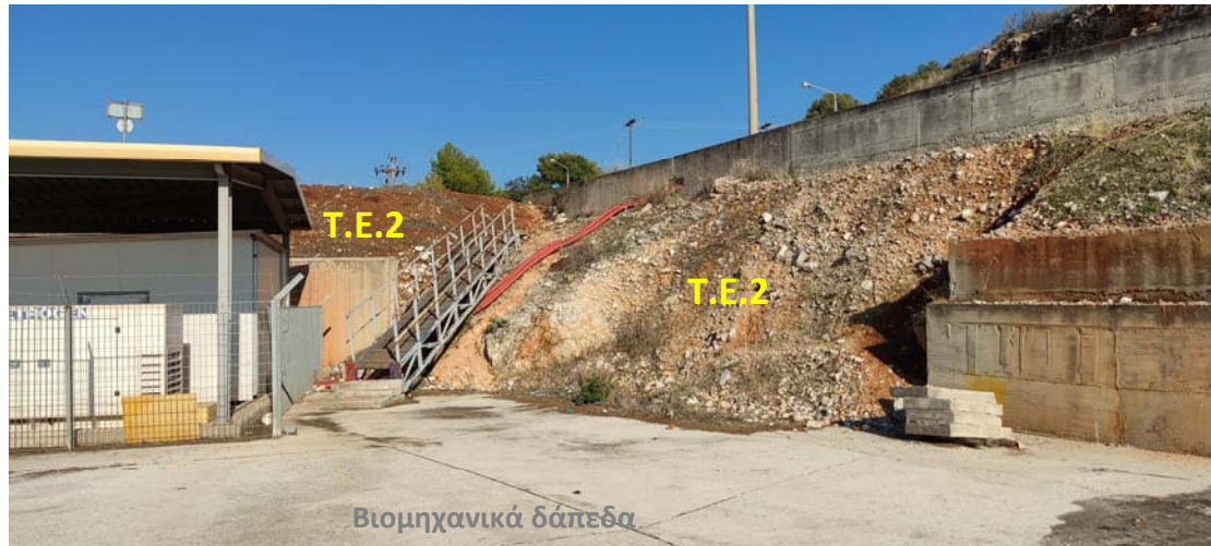
Φ14. Απεικόνιση της κοκκομετρικής διαβάθμισης και λιθολογίας των υλικών επιχωμάτων (T.E.2).
