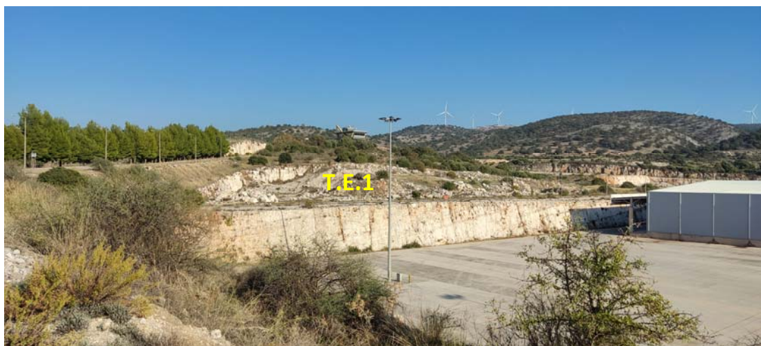
Φ23. Περιοχή απόθεσης υλικών εκσκαφών (ΤΕ1) στο δυτικό τμήμα του γηπέδου
