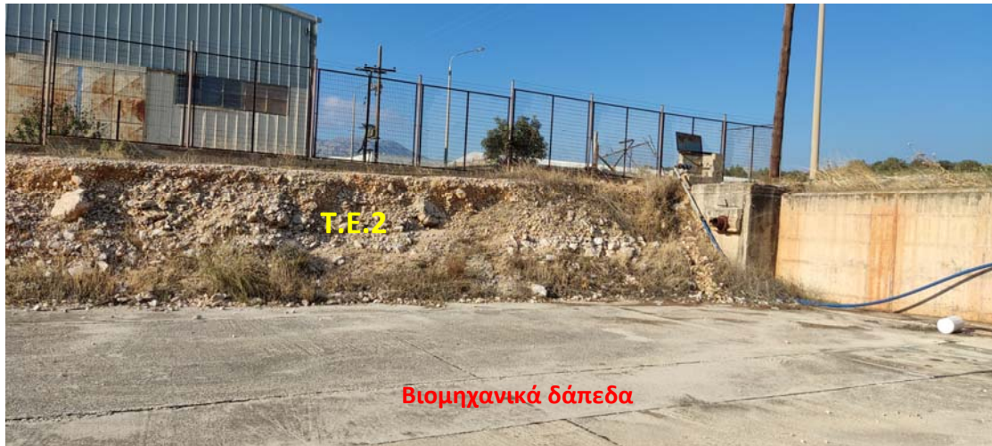
Φ16. Τυπική εμφάνιση των υλικών επιχωμάτων (T.E.2) ως δομικό υλικό έδρασης των επιμέρους κτηριακών υποδομών.
