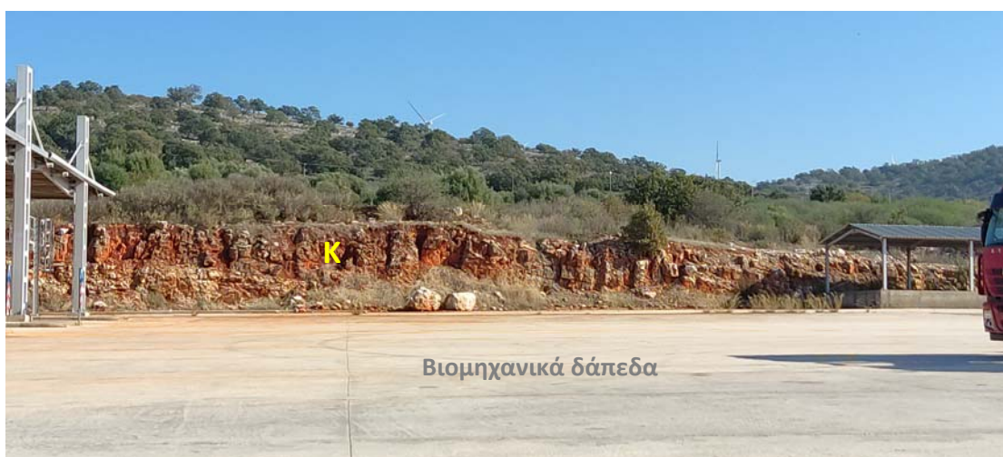
Φ5. Άποψη ασβεστολιθικού πρανούς (K) στο βορειοανατολικό τμήμα του γηπέδου.
