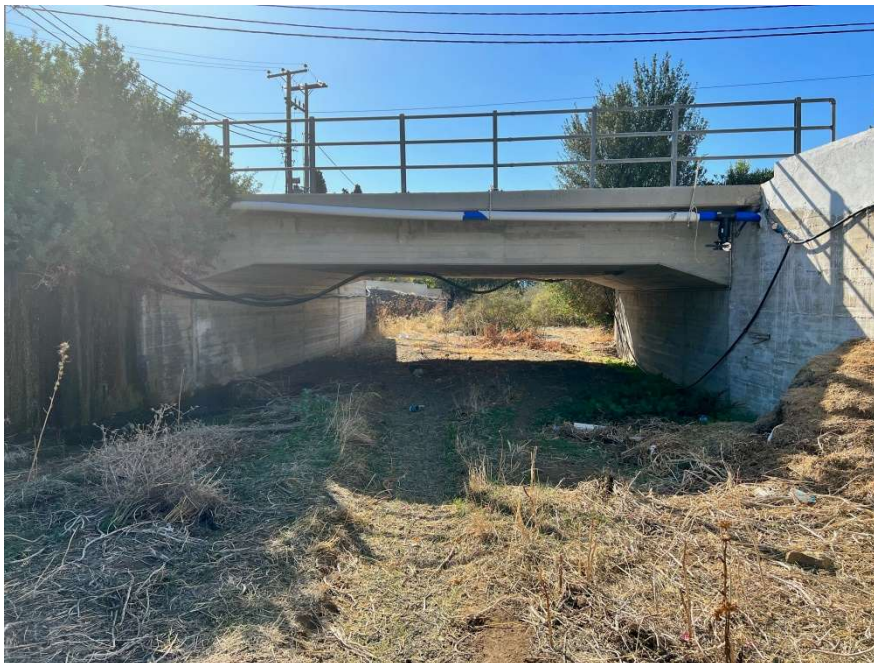
Φωτ.9. Άποψη της γέφυρας της επαρχιακής οδού και των γεωμετρικών της χαρακτηριστικών. Διακρίνεται η περί το ένα μέτρο χαμηλότερη από τη στάθμη της οδού θέση του κορυφαίου του αγωγού.
