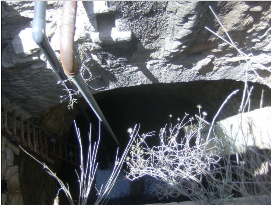
Φωτ.8. Φρέαρ και ελεύθερη επιφάνεια του προσχωματικού υδροφόρου ορίζοντα σε βάθος περί τα 4m. Διακρίνεται η υδροληπτική διάταξη και ο τρόπος διάνοιξης του φρέατος.
