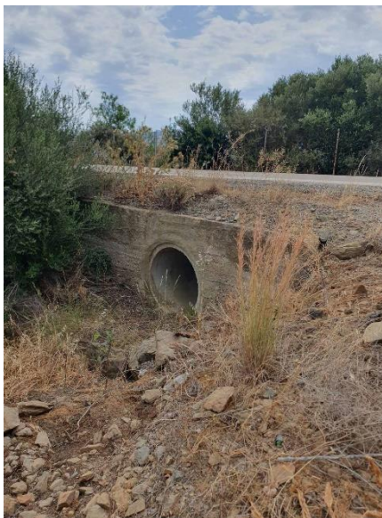
Εικόνα 3-10 Είσοδος τεχνικού οδοποιίας Φ1000 ρέματος 6 επί της επαρχιακής οδού Νο.58 (από ανάντη προς κατάντη)
