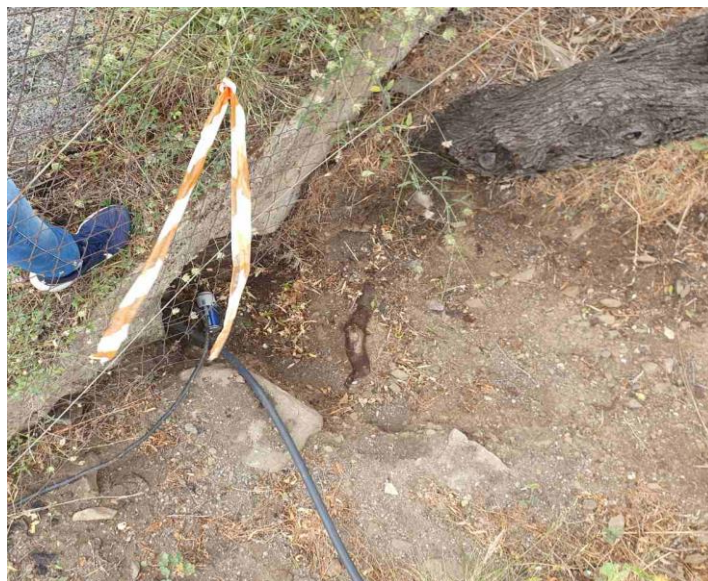
Εικόνα 3-11 Είσοδος τεχνικού οδοποιίας Φ400 ρέματος 7 επί της επαρχιακής οδού Νο.58 (από ανάντη προς κατάντη)
