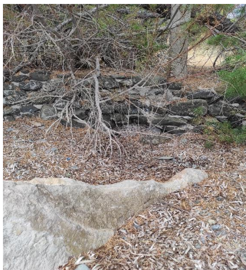
Εικόνα 3-7 Εκβολή ρέματος 3 στη θάλασσα – Αγωγός Φ1000 που χρήζει καθαρισμού (από κατάντη προς ανάντη)
