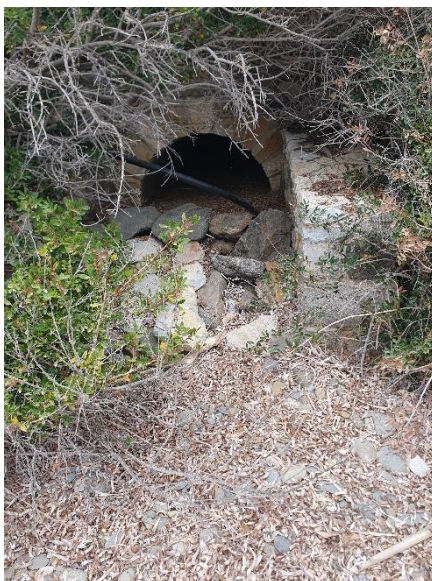
Εικόνα 3-3 Εκβολή ρέματος 2, σωληνωτού αγωγού Φ1000 ρέματος 2 (από κατάντη προς ανάντη)
