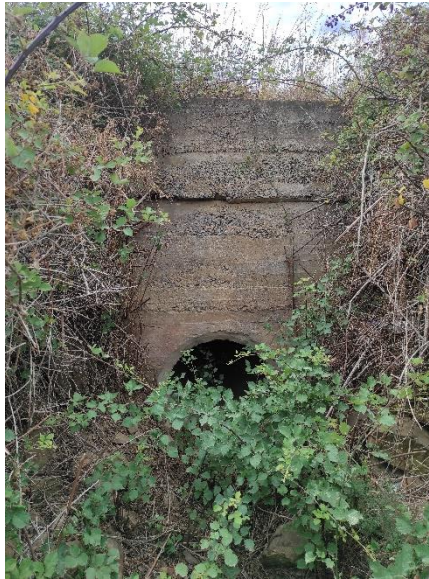
Εικόνα 3-9 Είσοδος τεχνικού οδοποιίας Φ1000 ρέματος 5 επί της επαρχιακής οδού Νο.58 (από ανάντη προς κατάντη)
