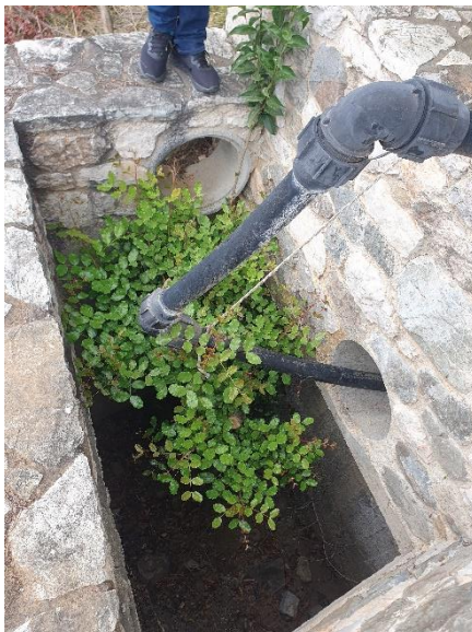
Εικόνα 3-2 Φρεάτιο πτώσης ρέματος 2, αμέσως κατάντη της επαρχιακής οδού Νο.58 - έξοδος σωληνωτού αγωγού Φ400 ρέματος 2 (από κατάντη προς ανάντη)
