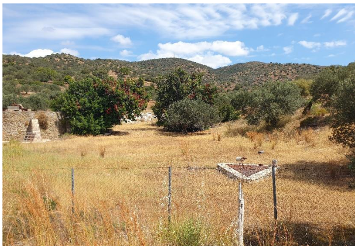
Εικόνα 3-4 Φρεάτια επίσκεψης αγωγού Φ1000 ρέματος 3, ανάντη επαρχιακής οδού Νο.58 (από κατάντη προς ανάντη)
