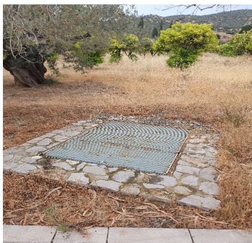
Εικόνα 3-5 Φρεάτια επίσκεψης αγωγού Φ1000 ρέματος 3, κατάντη επαρχιακής οδού Νο.58 (από κατάντη προς ανάντη)
