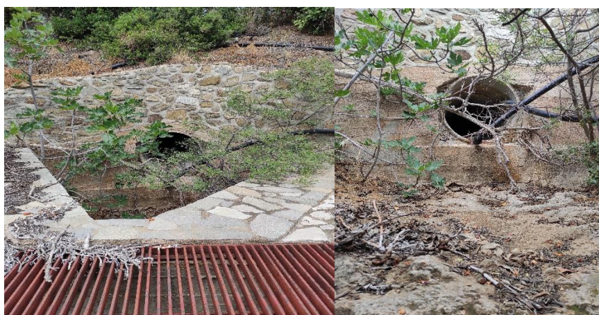
Εικόνα 3-6 Ρέμα 3 - Έξοδος τεχνικού επαρχιακής οδού Νο.58 - αγωγός Φ1000 (από κατάντη προς ανάντη)
