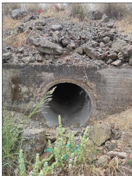
Εικόνα 3-8 Είσοδος τεχνικού οδοποιίας Φ1000 ρέματος 4 επί της επαρχιακής οδού Νο.58 (από ανάντη προς κατάντη)
